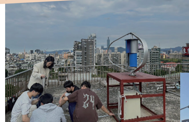
風力發電機實際安裝照片
